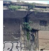
Foto 08 - Vazamento pelas juntas / peça danificada
