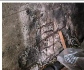
Foto 06 - Pilar com armadura exposta
