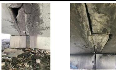
Foto 08 - Vazamento pelas juntas / peça danificada
