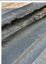
Foto 07 - Guarda Rodas danificado / fiação exposta
