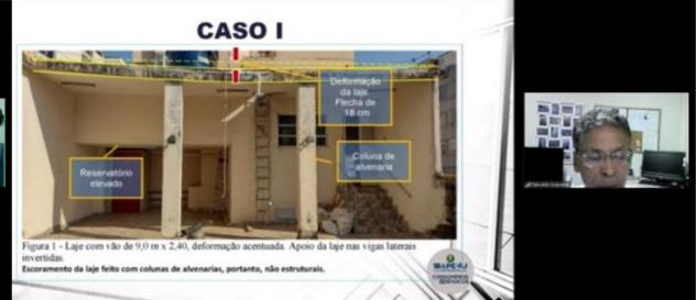
Figura 1 - Laje com vão de 9,0 m x 2,40, deformação acentuada. Após da laje nas vigas laterais invertidas. Escoramento da laje feito com colunas de alvenaria, portanto, não estruturais.
